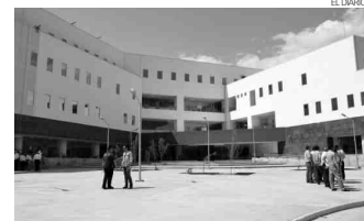
Amantes de lo ajeno robaron más de dos kilómetros de cableado en las nuevas instalaciones del IMSS.
