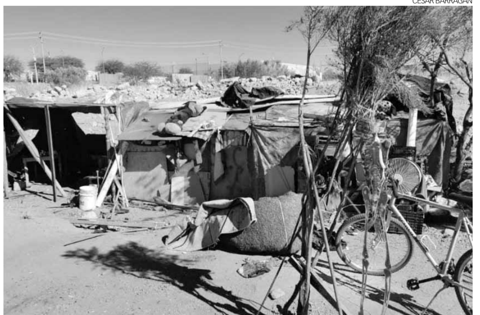
Vivienda hecha con restos de cartón, madera, plástico negro, sin ningún servicio básico y sobre los arbustos (en el monte).
