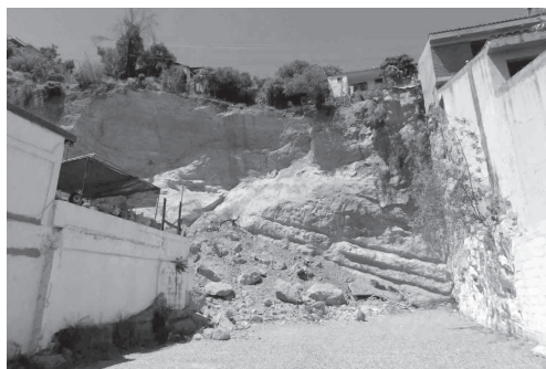
El desgajamiento del cerro en el centro de la ciudad, tiene en la zozobra a los vecinos del callejón Sordía.
