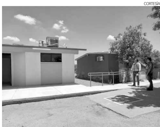
Las los planteles de educación básica en la capital del Estado serán rehabilitados por parte del Instituto Sonorense de Infraestructura Educativa (ISIE).
